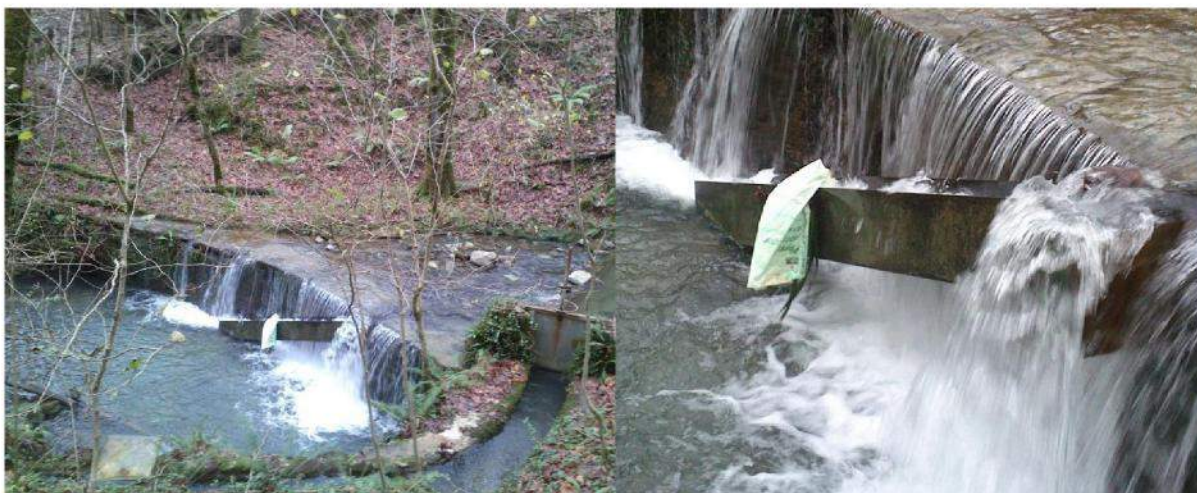
Azud en Altzolaras y detalle de escala metálica. Fuente visita inspección 11-12-2014
