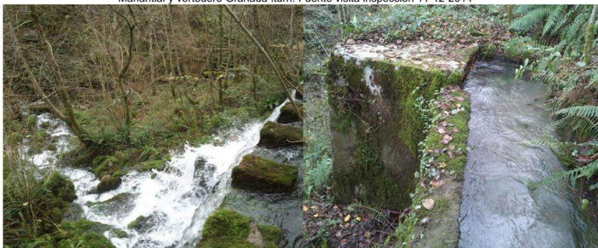
Vertedero y arqueta entrada sifón. Fuente visita inspección 11-12-2014
